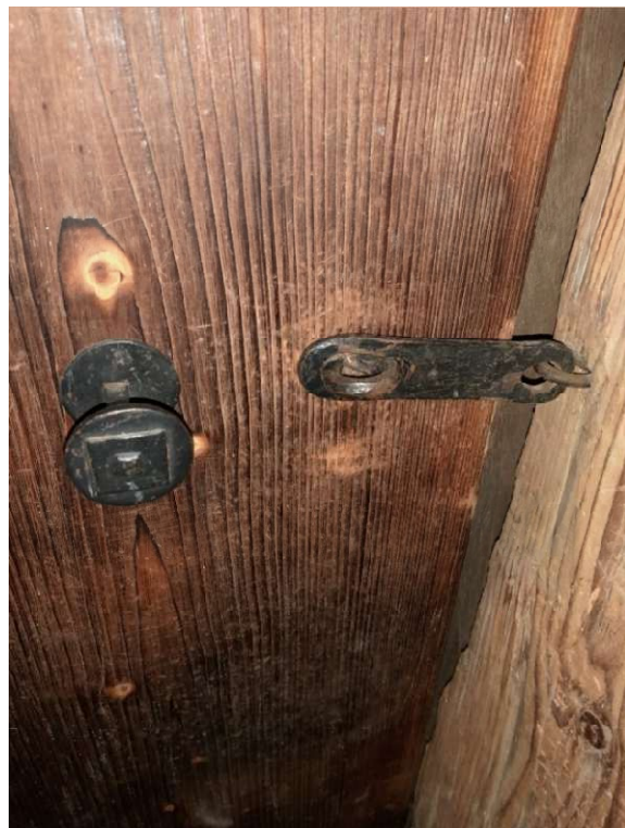
Obr. č. 31 – Detail kování vstupních dveří na věž
