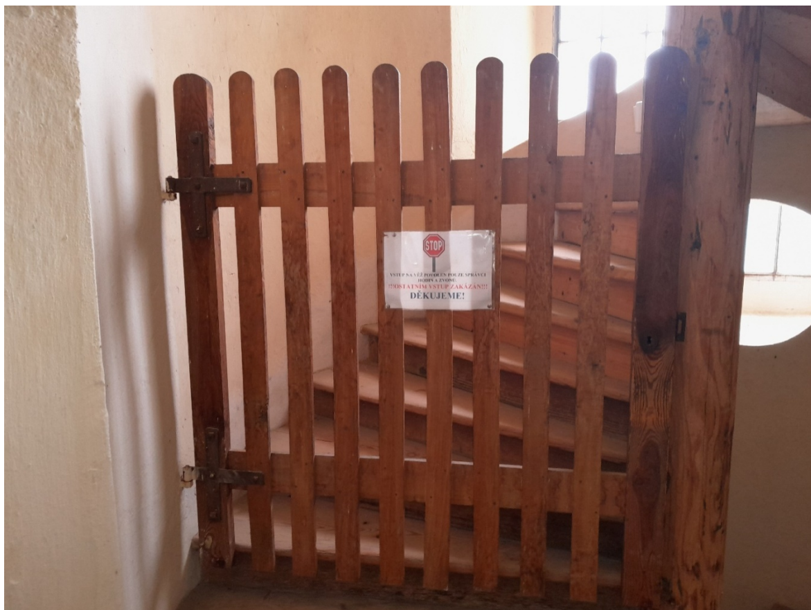
Obr. č. 17 – Dřevěná branka pro zabránění nepovolanému vstupu na půdu kostela
