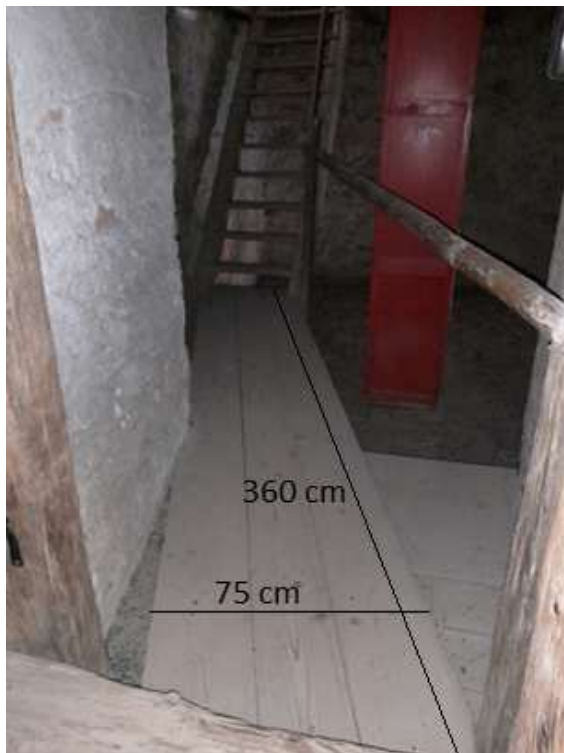
Obr. č. 39 – Dřevěná lávka ve vstupním podlaží věže s rozměry
