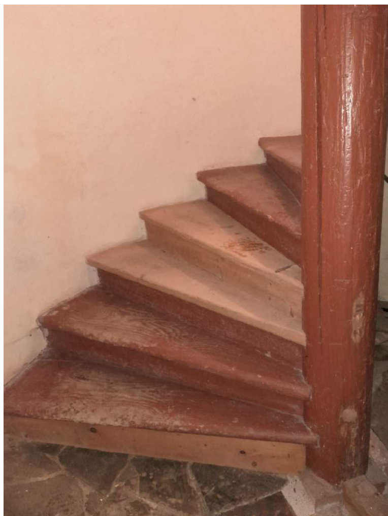
Obr. č. 3 - Nástupní stupně dřevěného točitého schodiště
