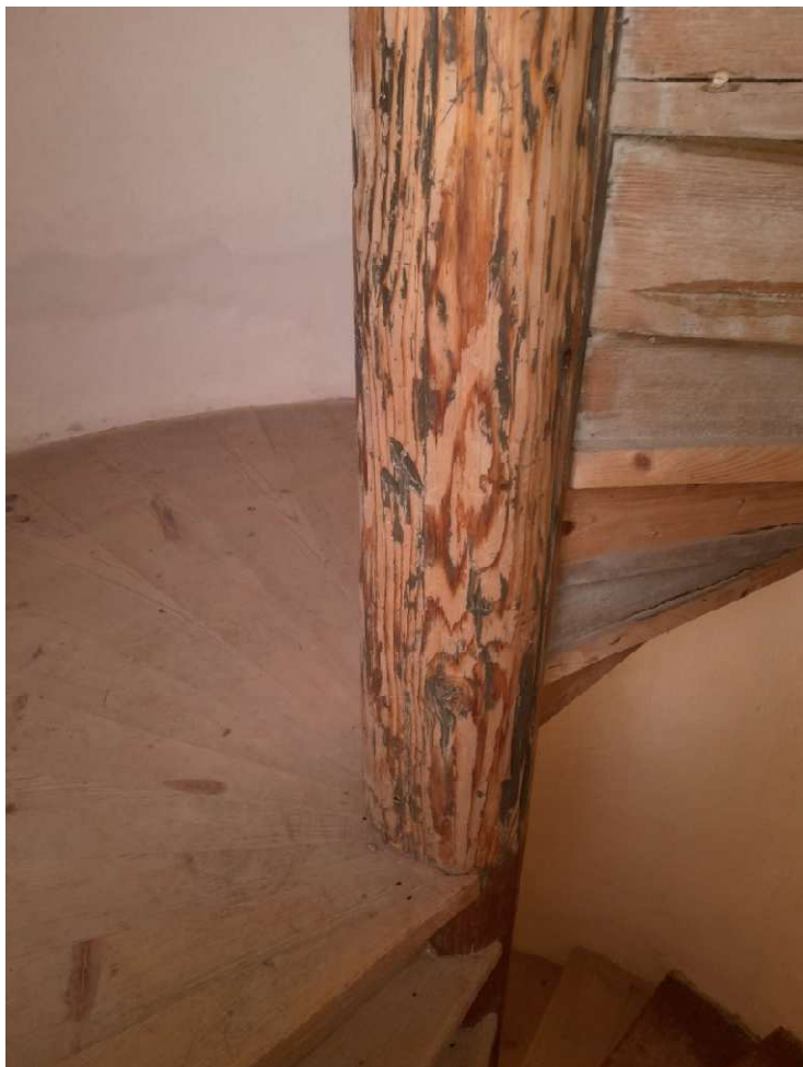
Obr. č. 9 – Vřeteno točitého schodiště
