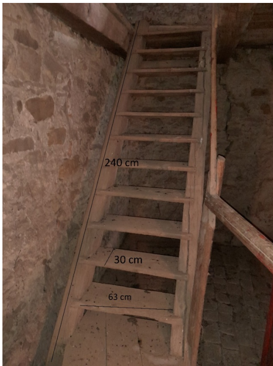
Obr. č. 40 – Schodišťové rameno pro vstup do podlaží hodinového stroje
