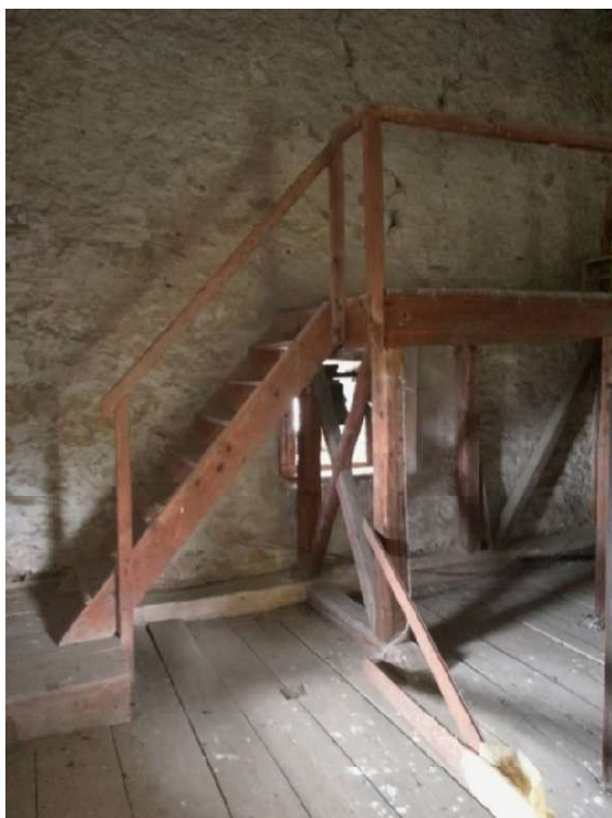
Obr. č. 51 – Schodiště 3NP vedoucí do zvonového podlaží
