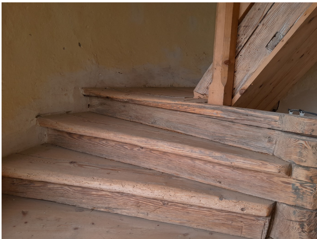
Obr. č. 13 – přechod točitého schodiště na žebříkové přímé schodišťové rameno
