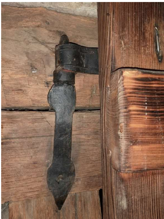
Obr. č. 30 – Detail kování vstupních dveří na věž
