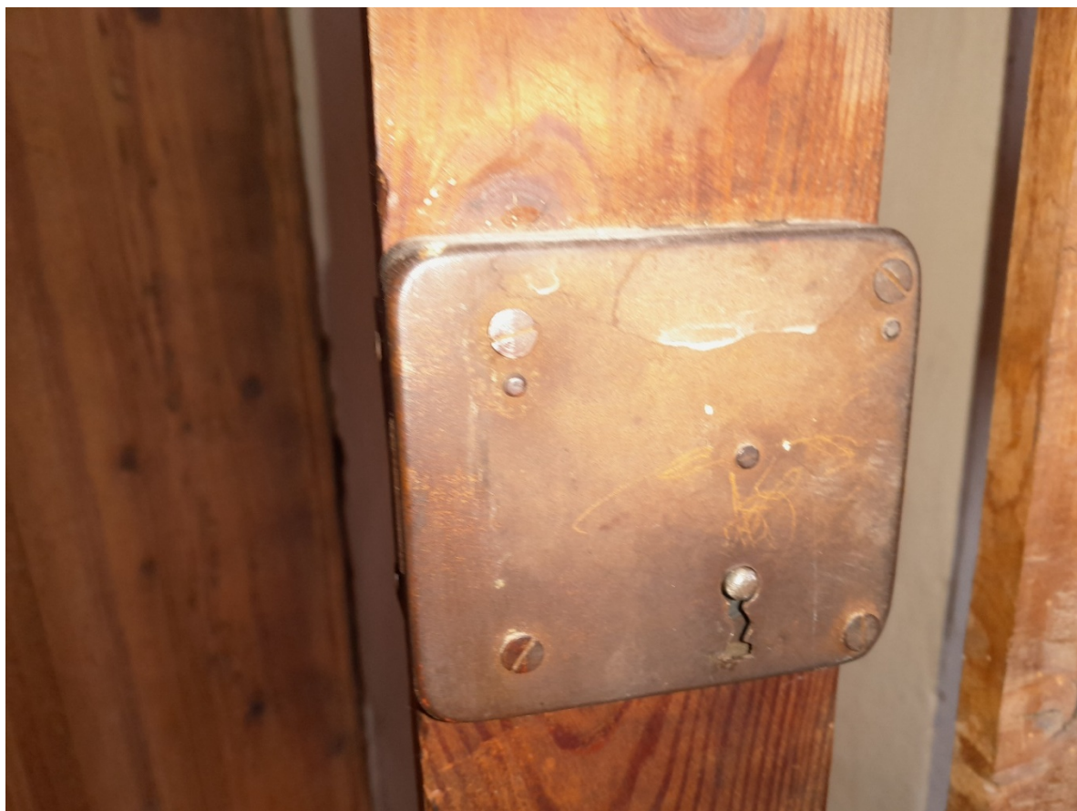
Obr. č. 18 – Dřevěná branka – detail zámku
