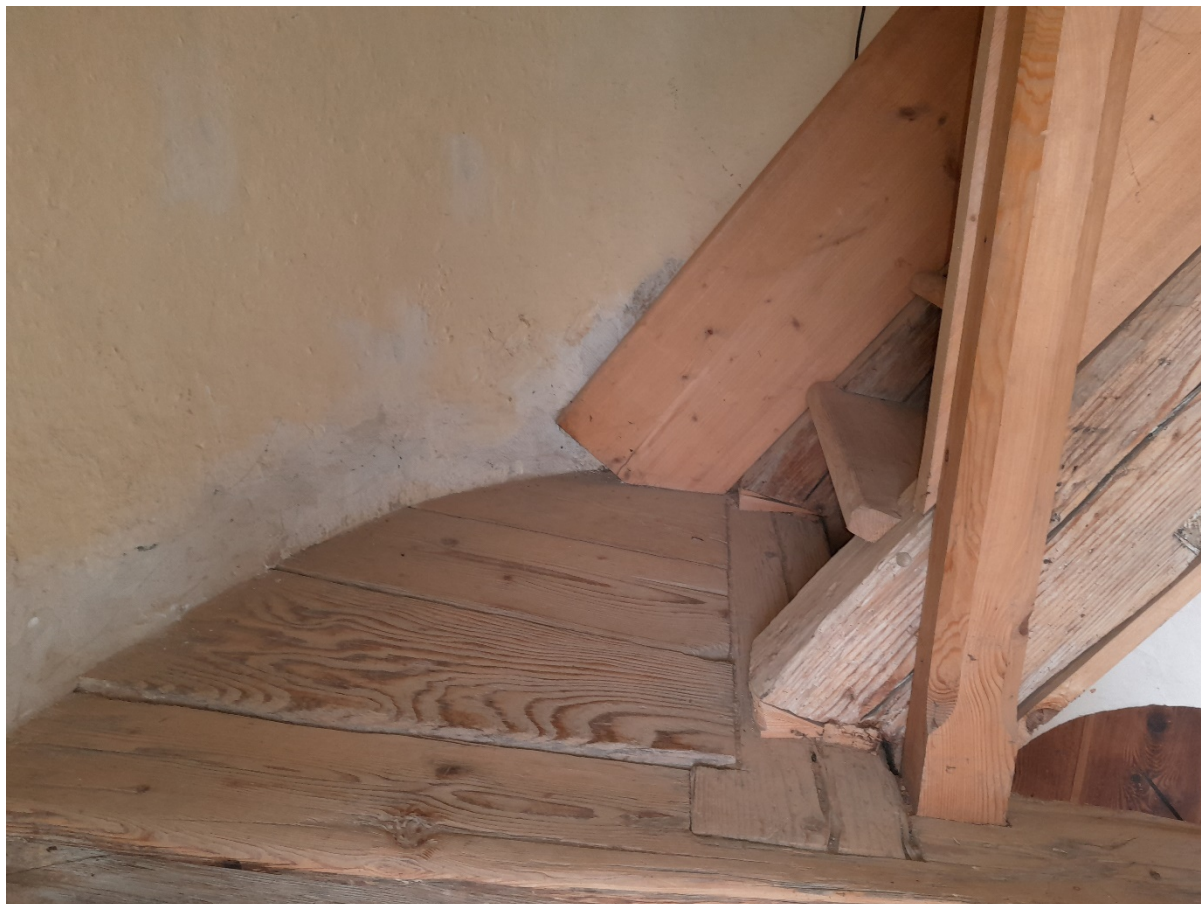
Obr. č. 14 – Podesta přechodu točitého schodiště na přímé rameno vedoucí na půdu
