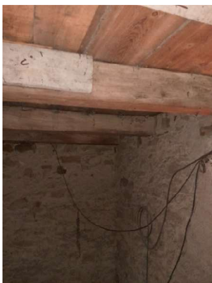
Obr. č. 44 – Konstrukce podlahy podlaží hodinového stroje – pohled ze spodní strany (ze vstupního podlaží věže)
