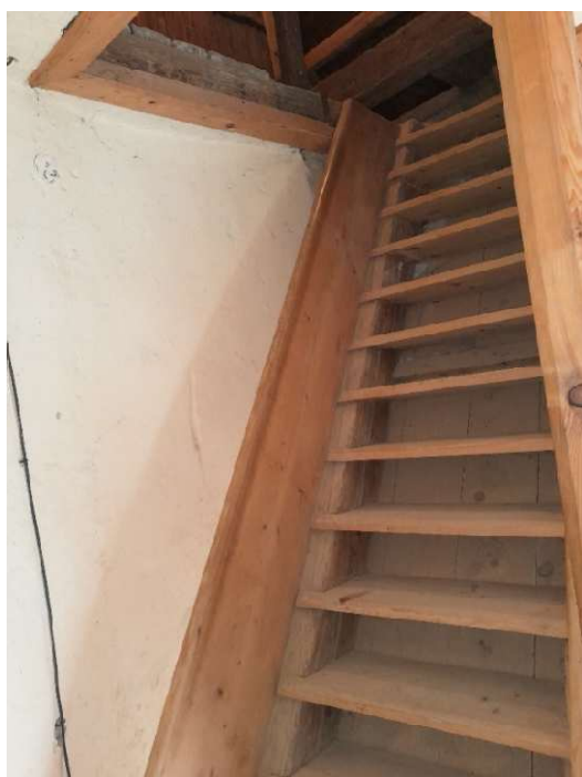
Obr. č. 15 – Žebříkové schodiště na půdu
