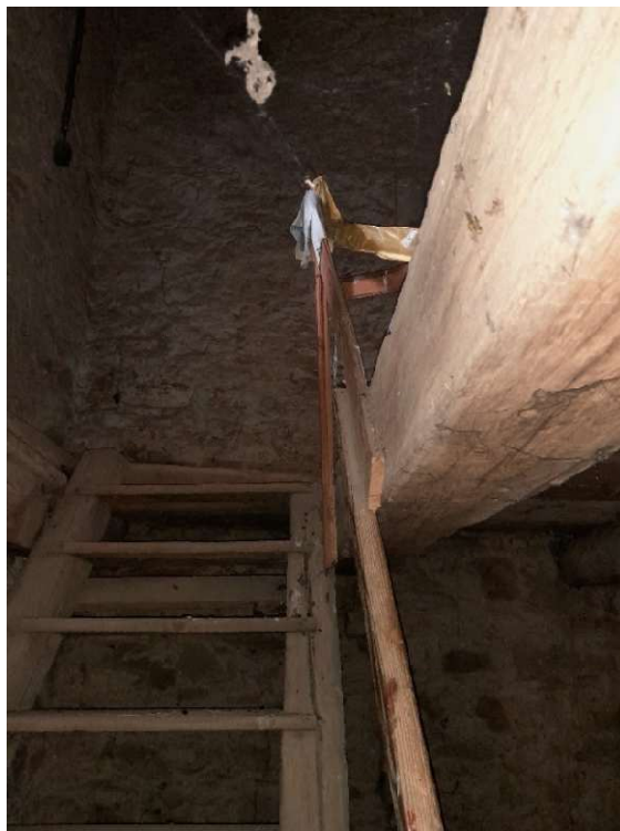
Obr. č. 41 – Zábradlí schodiště pro vstup do podlaží hodinového stroje
