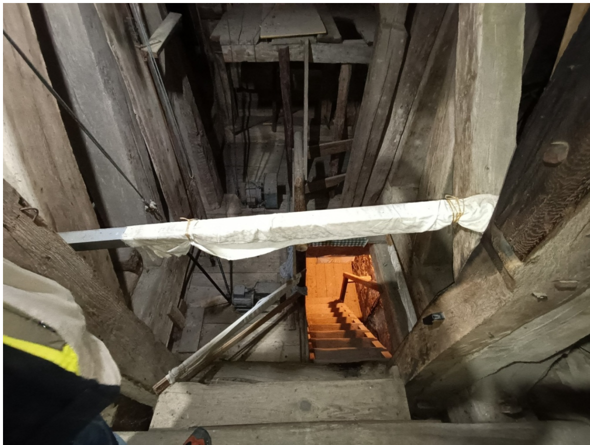
Obr. č. 59 – Zábradlí a provizorní zábrana kolem schodišťového otvoru ve 4NP
