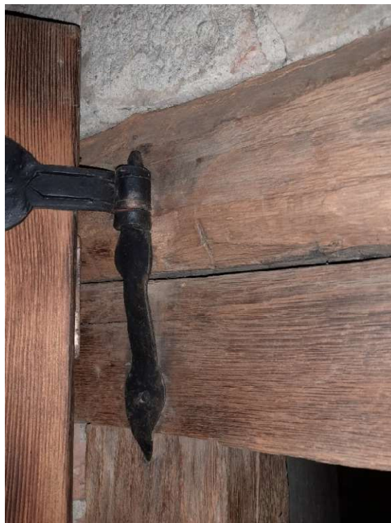
Obr. č. 37 – Detail kování vstupních dveří na věž
