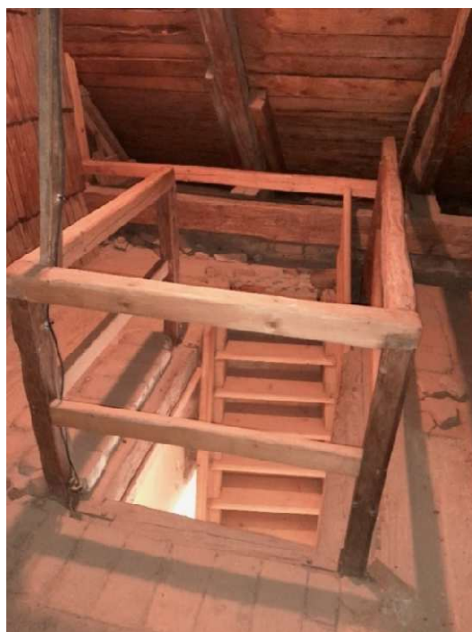
Obr. č. 16 – Žebříkové schodiště pohled z půdy
