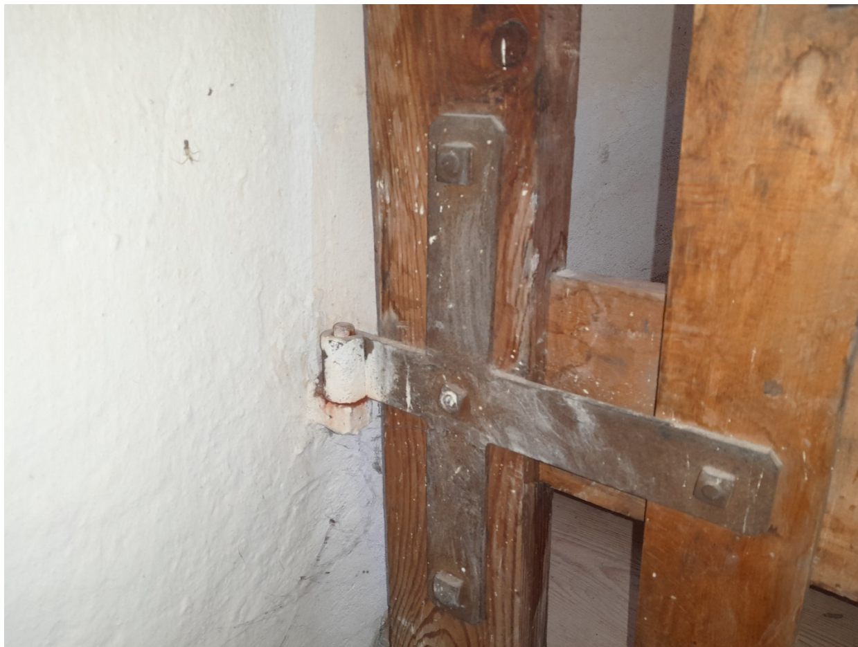
Obr. č. 19 – Dřevěná branka – detail závěsu
