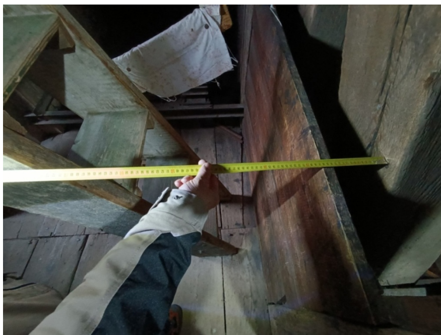
Obr. č. 62 – Žebříkové schodišťové rameno pro přístup do mezipatra
