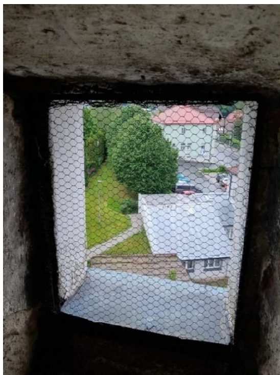
Obr. č. 50 – Rám s výplní větracích otvorů
