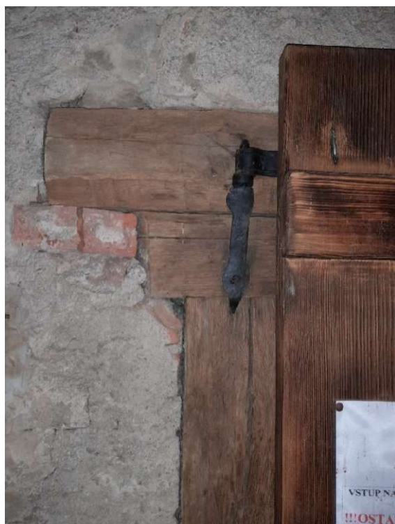
Obr. č. 34 – Detail kování vstupních dveří na věž
