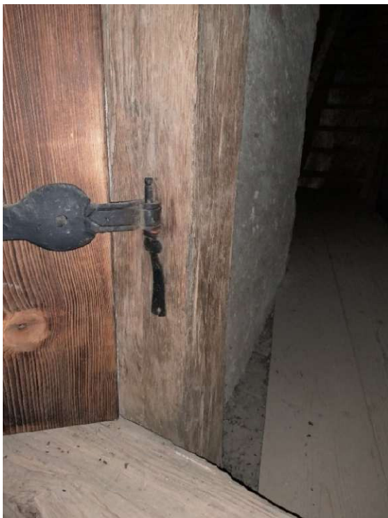
Obr. č. 36 – Detail kování vstupních dveří na věž
