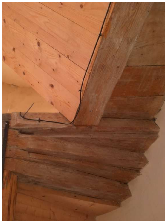
Obr. č. 12 – Ukončení točitého schodiště ze spodní strany
