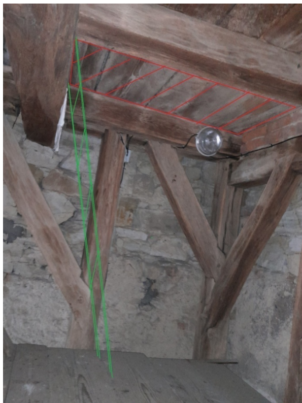
Obr. č. 69 – Znázornění posunu schodišťového ramene a otvoru
