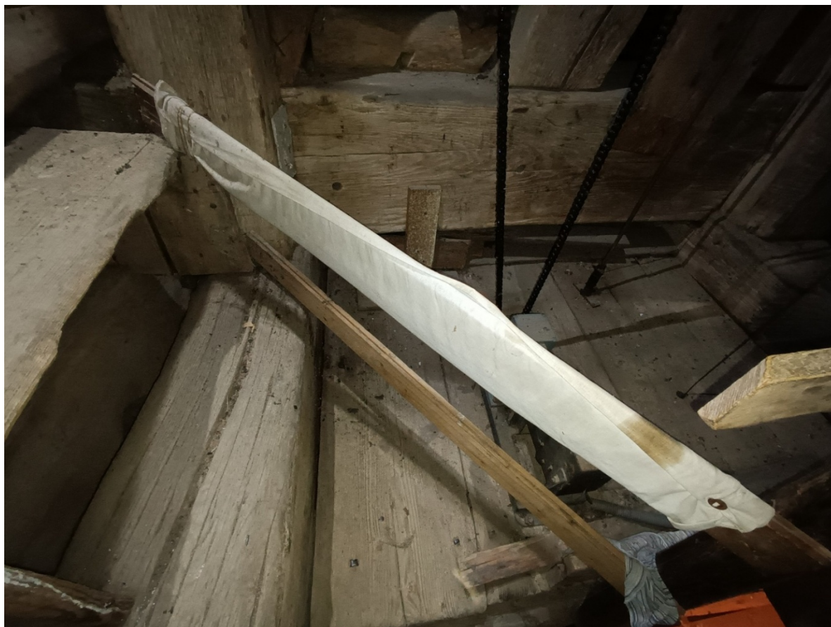
Obr. č. 58 – Zábradlí a provizorní zábrana kolem schodišťového otvoru ve 4NP
