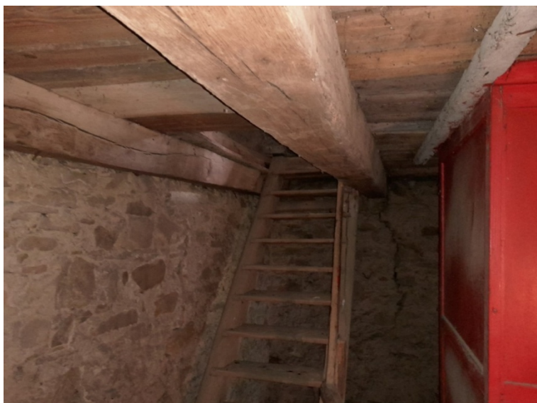
Obr. č. 45 – Konstrukce podlahy podlaží hodinového stroje – pohled ze spodní strany (ze vstupního podlaží věže)
