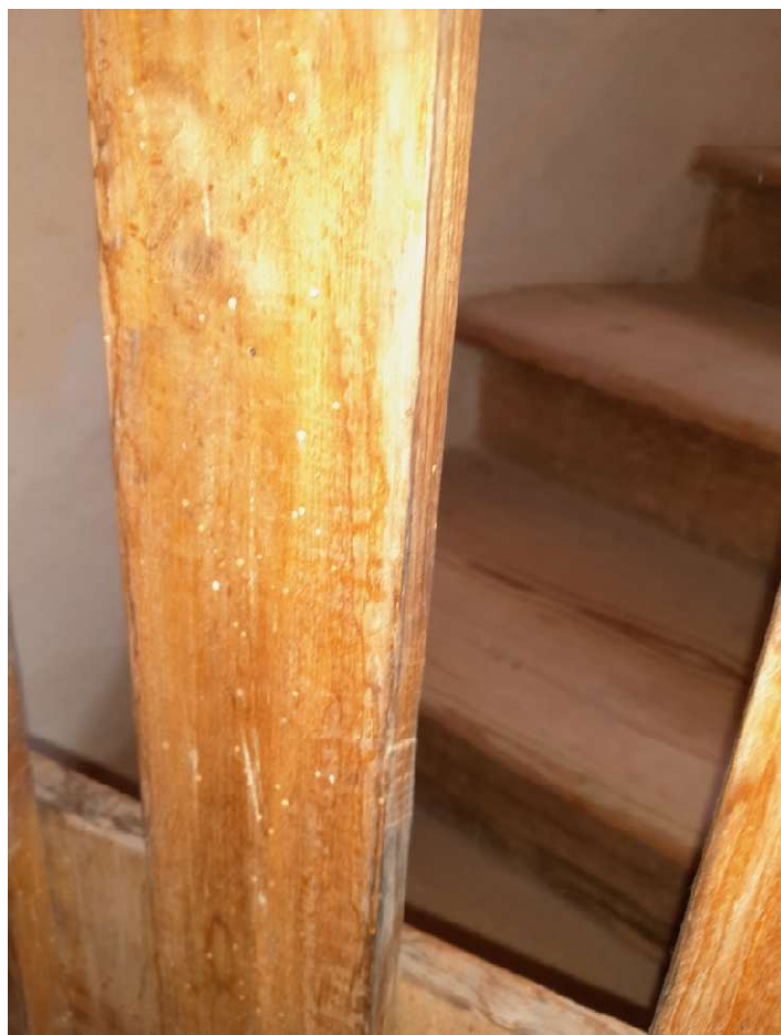
Obr. č. 20 – Dřevěná branka – detail poškození dřevokazným hmyzem
