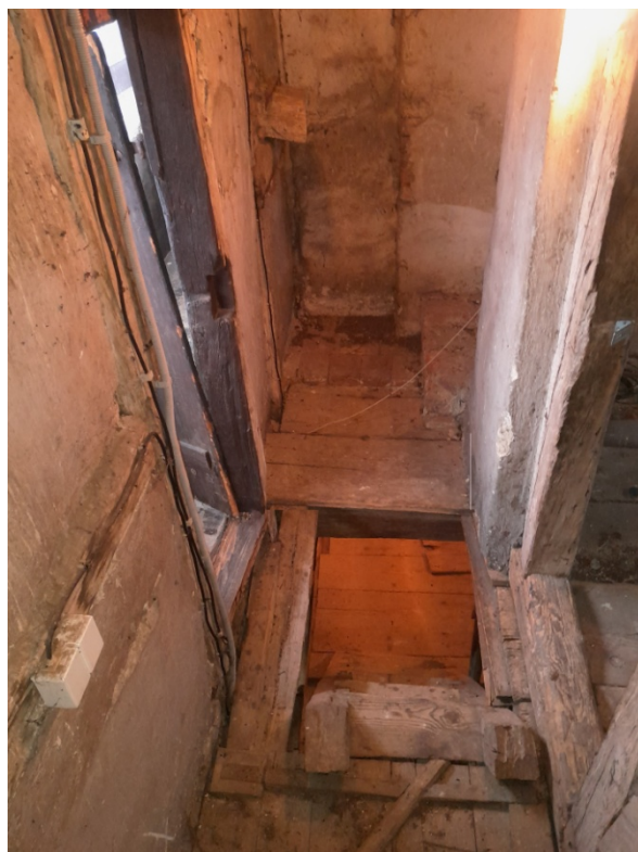
Obr. č. 67 – Schodišťové rameno a otvor mezi dveřmi do bývalé místnosti zvoníka a na ohoz
