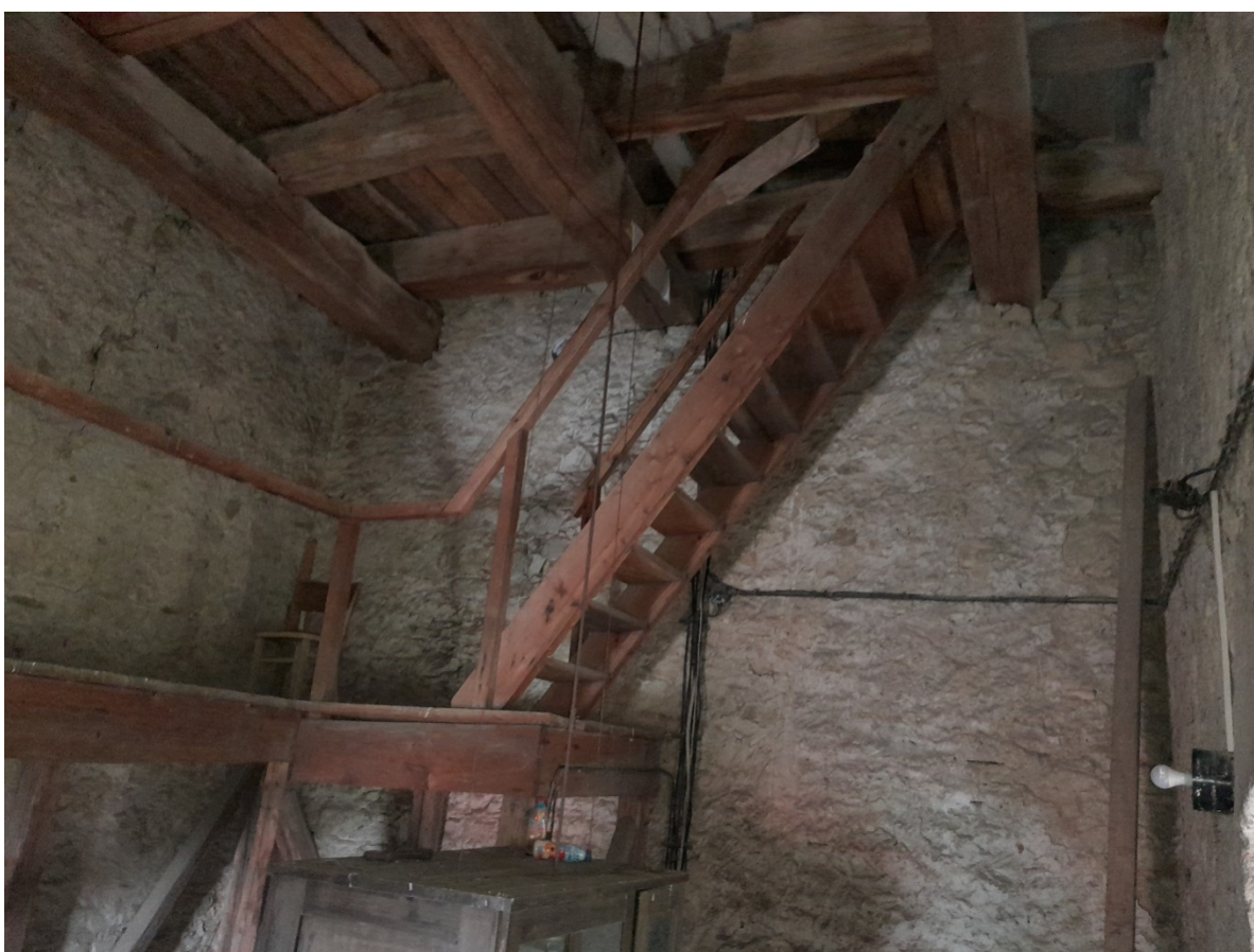
Obr. č. 54 – Schodiště vedoucí do zvonového podlaží
